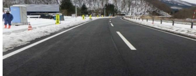
八幡平市安代と秋田県鹿角市の県境を繋ぐ、国道282号線の、道路改良工事を行いました。経年劣化による舗装表面を撤去して車道幅を広く整備し、それに伴い歩道や側溝などの排水整備、ガードパイプの新調、歩道にはブロックを設置し、交通事故等の可能性が軽減されました。また、近くを流れる佐比内川も護岸ブロックを施工し、自然災害の可能性が低減されました。
