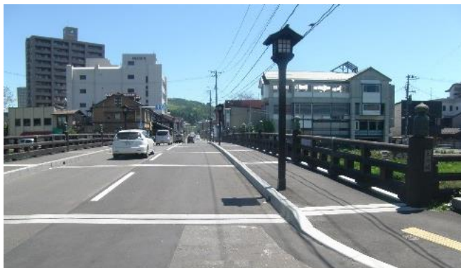
高欄に設置されている擬宝珠は、細心の注意を払い 撤去・再設置しました。
