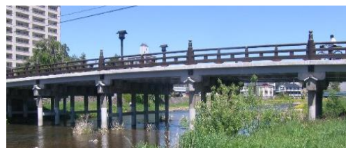
高欄に設置されている擬宝珠は、細心の注意を払い 撤去・再設置しました。
