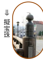
高欄に設置されている擬宝珠は、細心の注意を払い 撤去・再設置しました。
